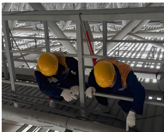
图 5.1.22-1 候车大厅屋盖检查
