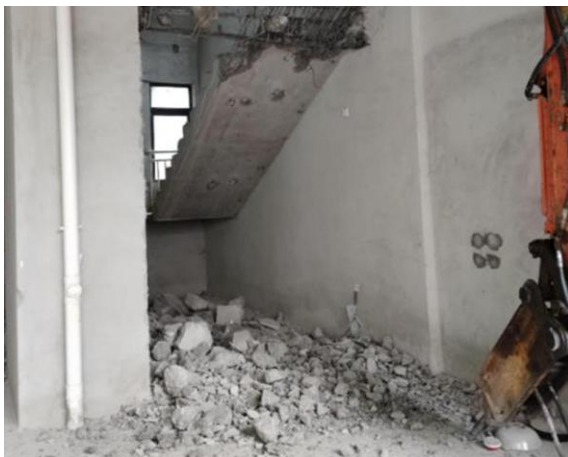
图 4.2.11-1 大型机械拆除楼梯
