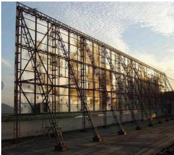
图 5.1.24-1 屋面大型广告牌
