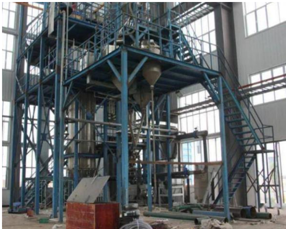
图 5.2.6-1 大型机械独立安装
