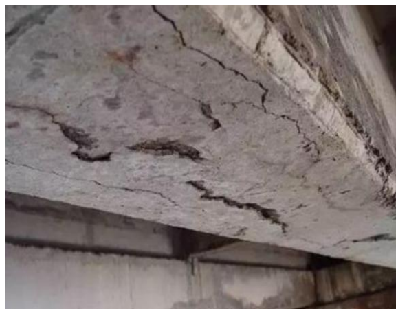
图 9.1.2-8 梁底部开裂
