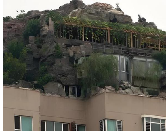
图 4.2.6-2 屋顶加建景观
