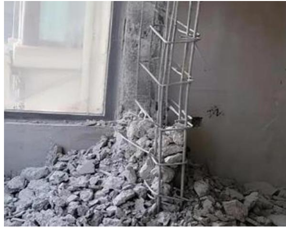
图 4.2.1-2 剪力墙拆除
